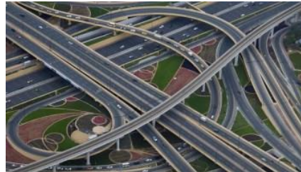
Figura 01 – viadutos em área urbana
