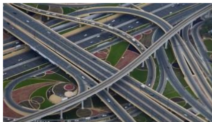
Figura 01 – viadutos em área urbana
